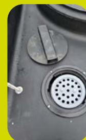
Préfiltre à brosse Sortie décanteur primaire
